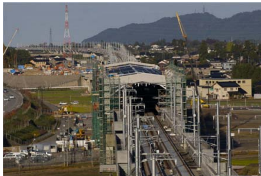
整備が進む新黒部駅(仮称)駅舎
