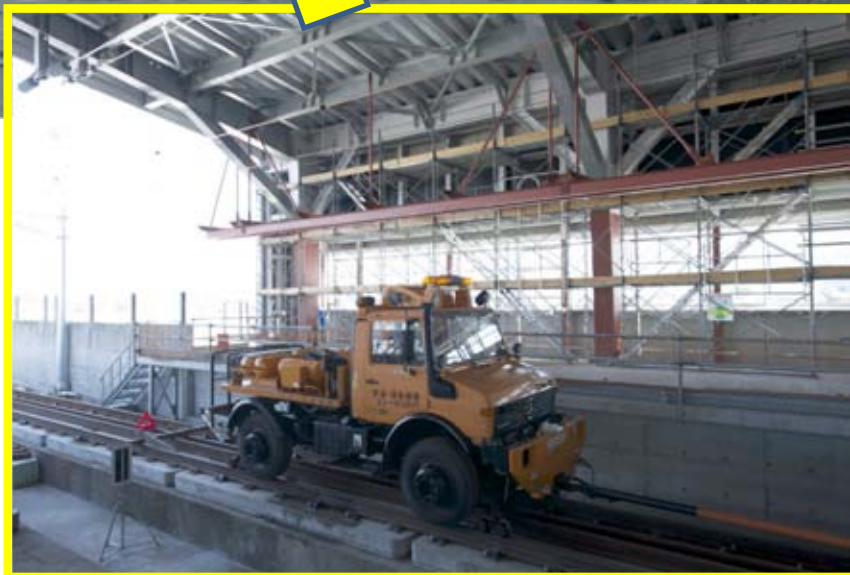
建設中の駅構内
