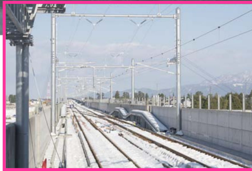
建設中の軌道(駅ホームより)
