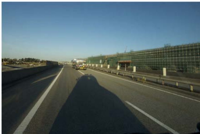
北陸自動車道下り線から駅舎を見る
